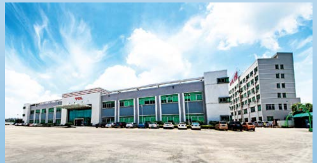
Jiujiang Base (2 εκ. σετ κλιματιστικών)
